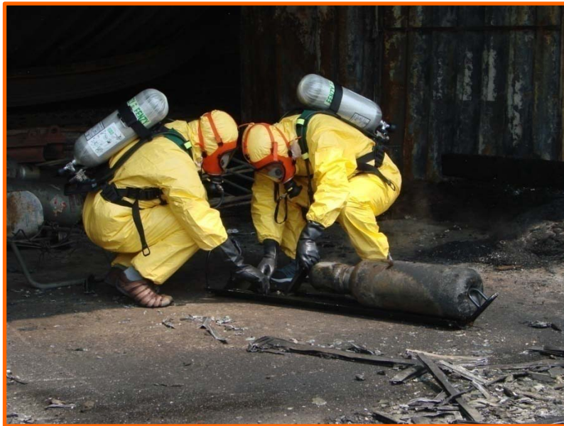
利用小型鋼瓶固定架 進行鋼瓶固定作業
