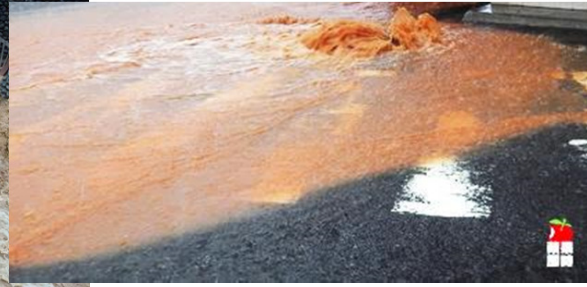
瞬間降雨量 超過 集液溝工程設計的上限，導致 滿溢
