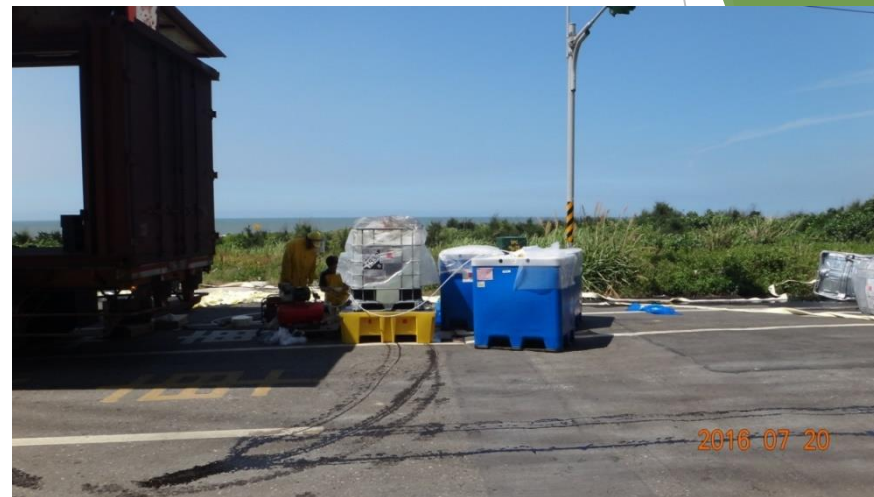
IBC TANK放置在洩漏盤上準備移槽
