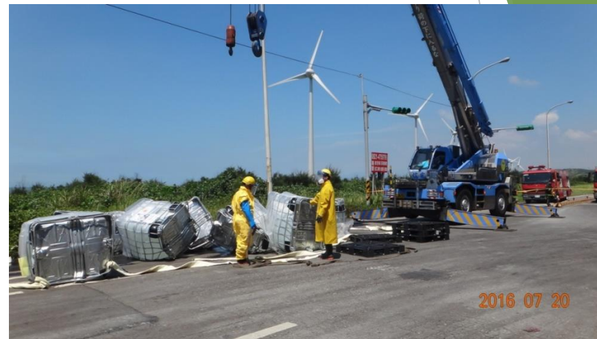
以大型吊車翻正傾倒的 TANK
